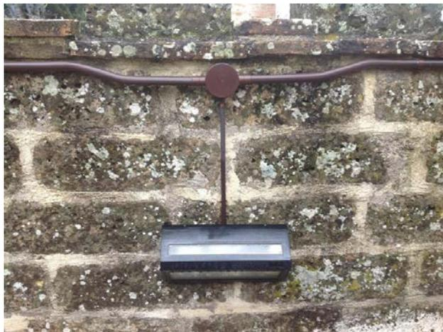
I corpi illuminanti da prospetto verranno integrati il più possibile tra la vegetazione o inseriti nel modo meno invasivo possibile sulle facciate dei fabbricati esistenti. Si suggerisce di trattare sia i pali di sostegno che i proiettori con vernice nera opaca ad alta resistenza.
